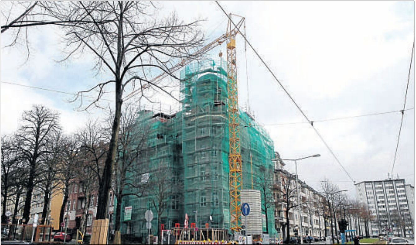
Noch hinter dem Gerüst versteckt: Türmchen und die Mansarde wurden nach historischem Vorbild wieder aufgebaut und zieren künftig das Wohn- und Geschäftshaus an der Ecke Querallee/Goethestraße.
